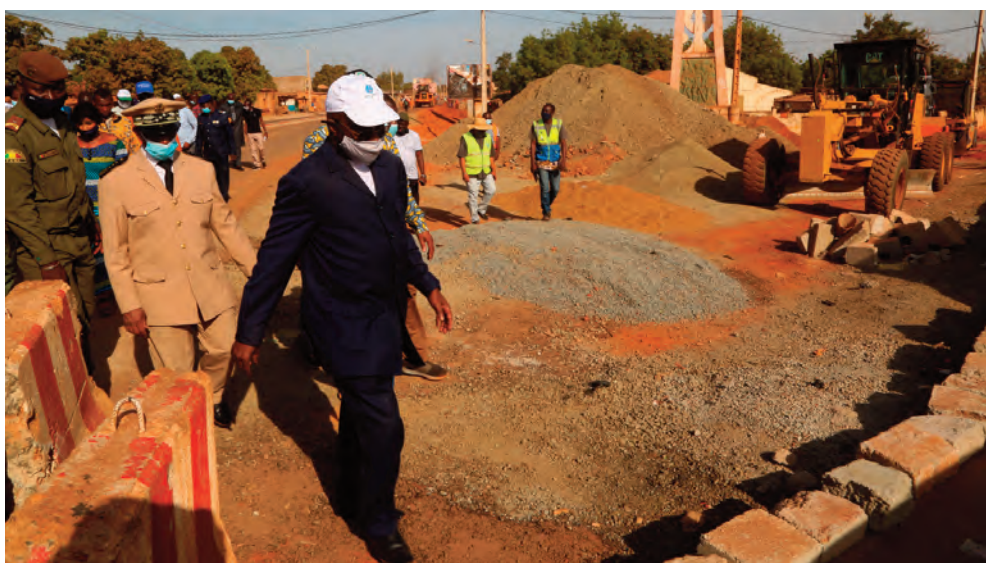
Le ministre Dabo sur un chantier de Sikasso
